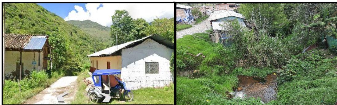
Imagen 2. Se aprecia densa vegetación, colmatación de cauce y viviendas asentadas en la riberas, vulnerables a una avenida máxima.
